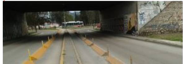
Imágenes 14-15-16 Tramo bajo calzada
