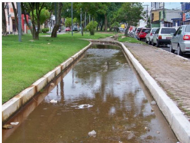
Imagem 1 Ciclovia na Av. Marquês de Herval com pontos de alagamento e sinuosidade acentuada
