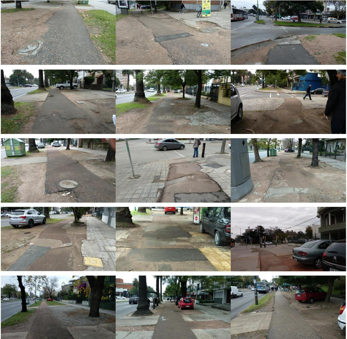
Figura 3: Imágenes del estado del pavimento de la bicisenda norte (agosto 2018)
